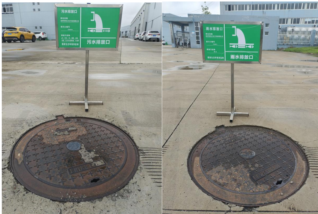
图 3-1 雨、污水总排口及标识牌
